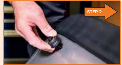
Insert tool & fit the back nut.
